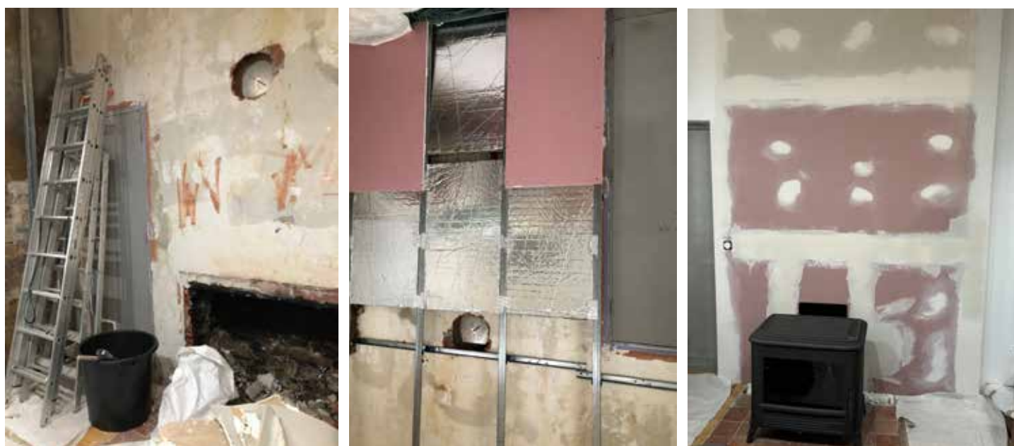
Pose du poêle dans le conduit d'une ancienne cheminée après travaux d'isolation
