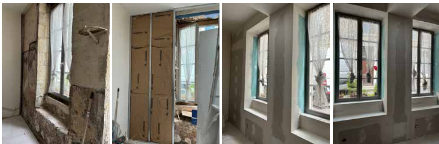
Isolation par l'intérieur
