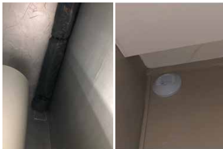
Pose d'une VMC hygro auto-réglable
