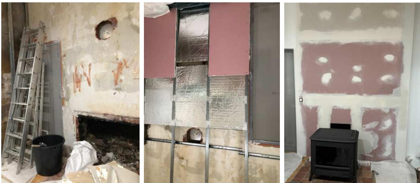
Pose du poêle dans le conduit d'une ancienne cheminée après travaux d'isolation
